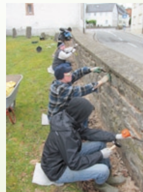
Ehrenamtliches Engagement bei der Sanierung der Kirchenmauer
